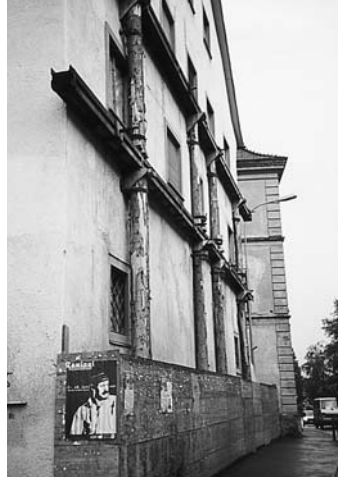
写真A●景観重要建造物 景観重要建造物に指定されると、現状の意匠、色彩の変更も許可を受けなければなりません。
