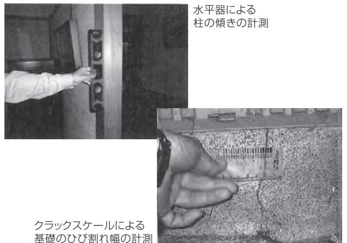
図2-2●建物状況調査の例
